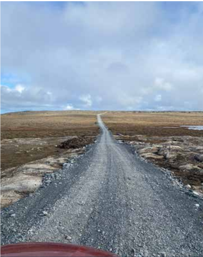
Anuriqjuak Nukkiksautiit Project access road
